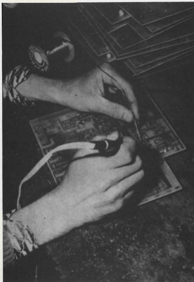
Fase di saldatura dei circuiti integrati sulla basetta stampata.
